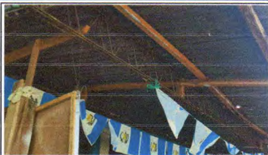
FOTO 7: Sustitución de estructura de soporte de metal, por metal
