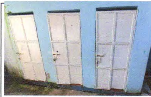
FOTO 4: Mantenimiento a estructura (lijado, cambio de tubo , cepillado, sujeciones, aplicación de pintura) a puertas servicios sanitarios
