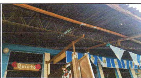
FOTO 6: Sustrucción de lámina, por lámina troquelada aluzinc calibre 26 AULAS
