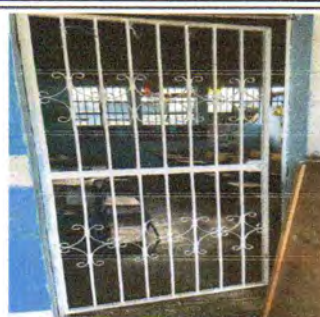
FOTO 8: Mantenimiento a estructura (lijado, cambio de tubo , cepillado, sujecciones, aplicación de pintura) PUERTAS EN AULAS
