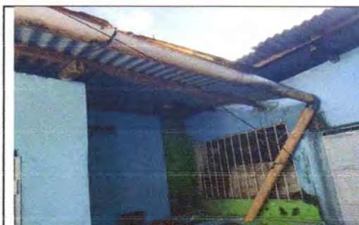
FOTO 3: Sustrucción de canal de metal Y Reparación de bajada de agua pluvial, tubo PVC 3"
