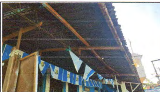
FOTO 9: Sustitución de canal de metal
