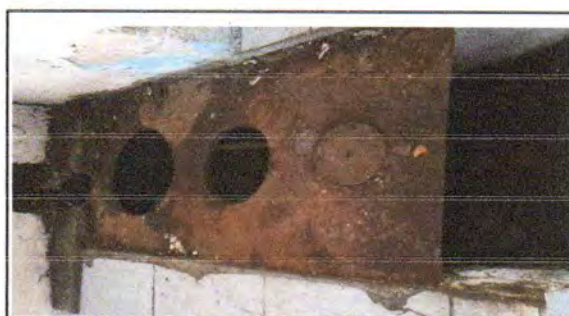
FOTO 12: Sustitución de plancha de metal de 3 hornillas
